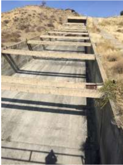
Նկ. 3. Աղետային բաց ջրհեռի միջնամասի և վերջնամասի տեսքերը
