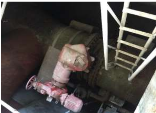
Նկ. 5. Իռիգացիոն ջրթողի սկավառակավոր և կոնական փականների տեսքերը
