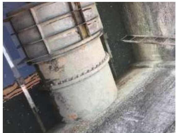
Նկ. 5. Իռիգացիոն ջրթողի սկավառակավոր և կոնական փականների տեսքերը
