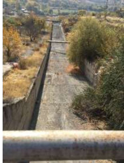
Նկ. 3. Աղետային բաց ջրհեռի միջնամասի և վերջնամասի տեսքերը
