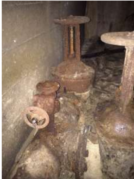
Նկ. 4. Ջրամբարի դատարկման խողովակաշարի և դրա վրա տեղադրված կարգավորման փականների վիճակը
