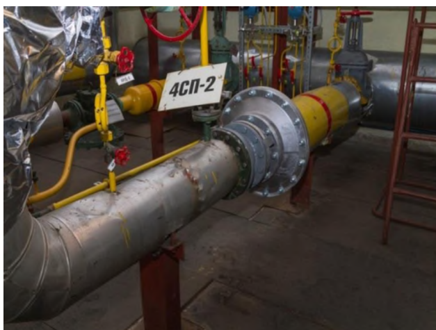
Рис. 5. Газовый редуктор РДП-200ВЛГ
