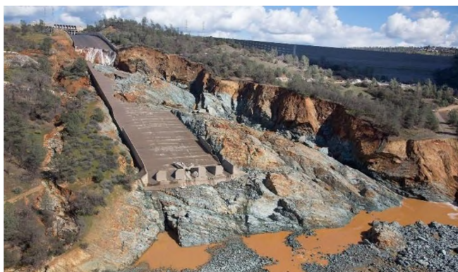
Рис 1. Плотина Оровилл (участок катастрофического водосброса)
