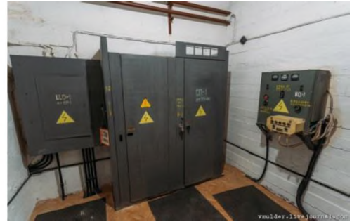
Նկ. 3. Պաշտպանական կառույցի էլեկտրամարակարարման վահաններ
