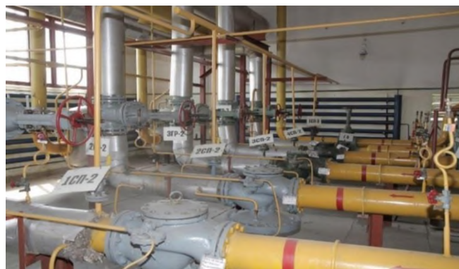
Рис. 1. Газораспределительный пункт городской котельной
