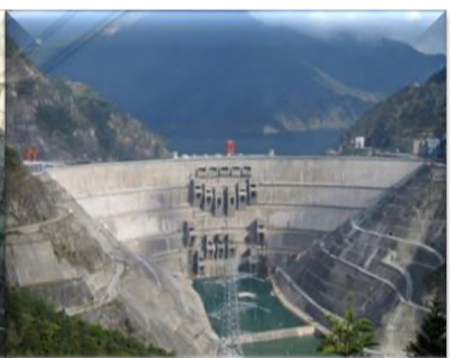
Հիդրոէներգետիկական նշանակության կամարակապ ամբարտակ (Չինաստան)
